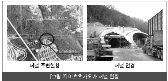
[그림 2] 이초츠가오카 터널 현황
